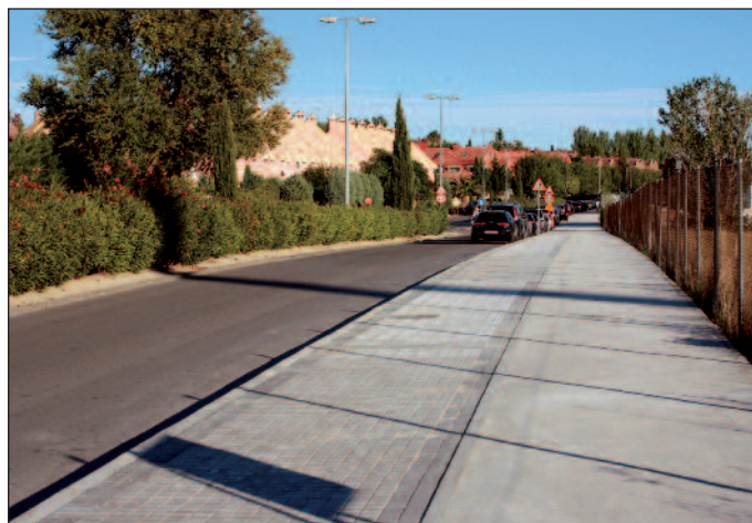
La Avenida Aristóteles durante las obras de remodelación.
